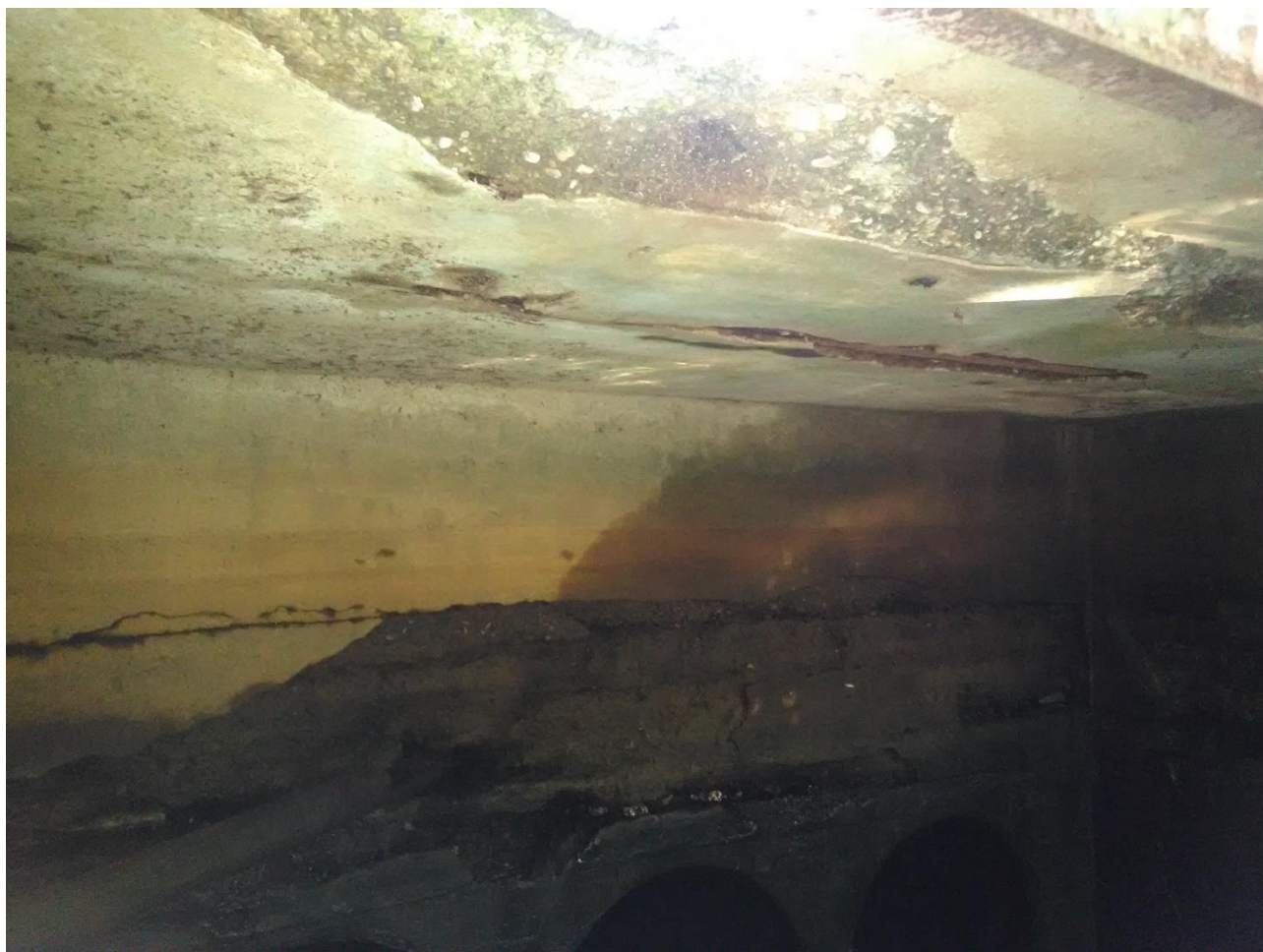
FOTO č.7 – vtokový objekt, degradace stropní desky
