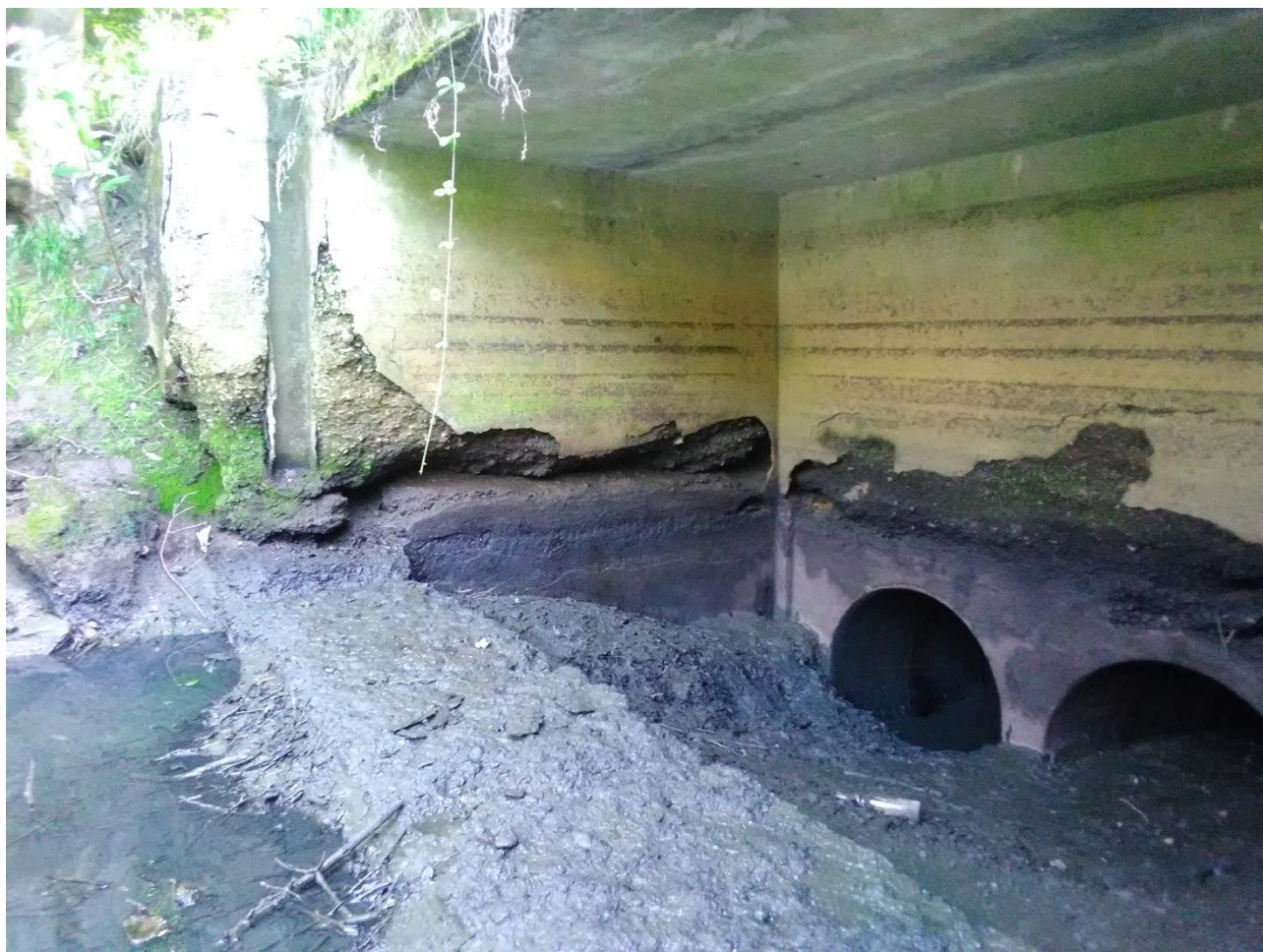
FOTO č.15 – výtokový objekt, degradace betonu na PB
