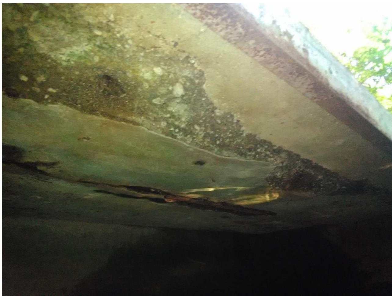
FOTO č.8 – vtokový objekt, degradace stropní desky
