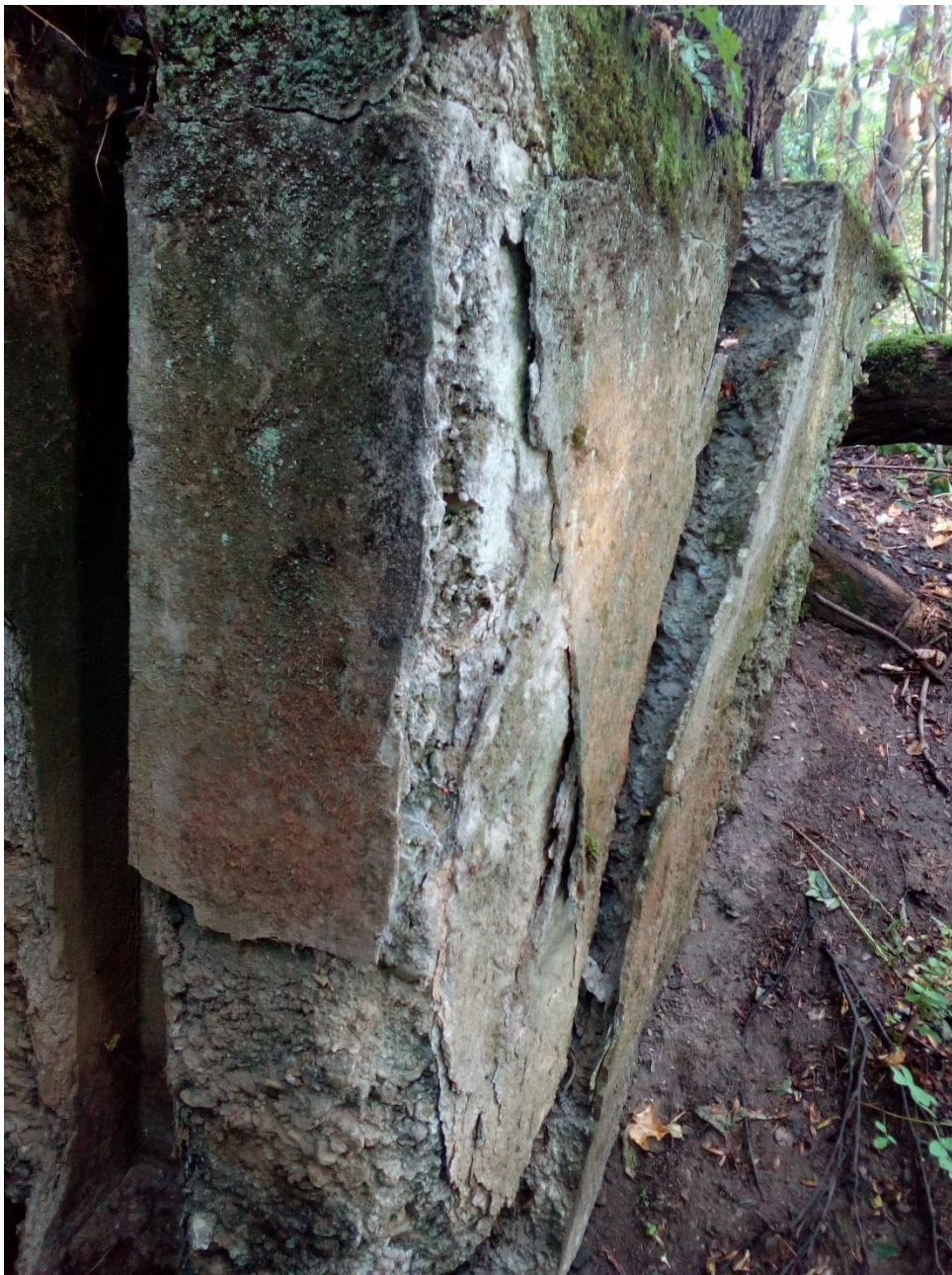
FOTO č.17 – výtokový objekt, trhlina v betonu na LB
