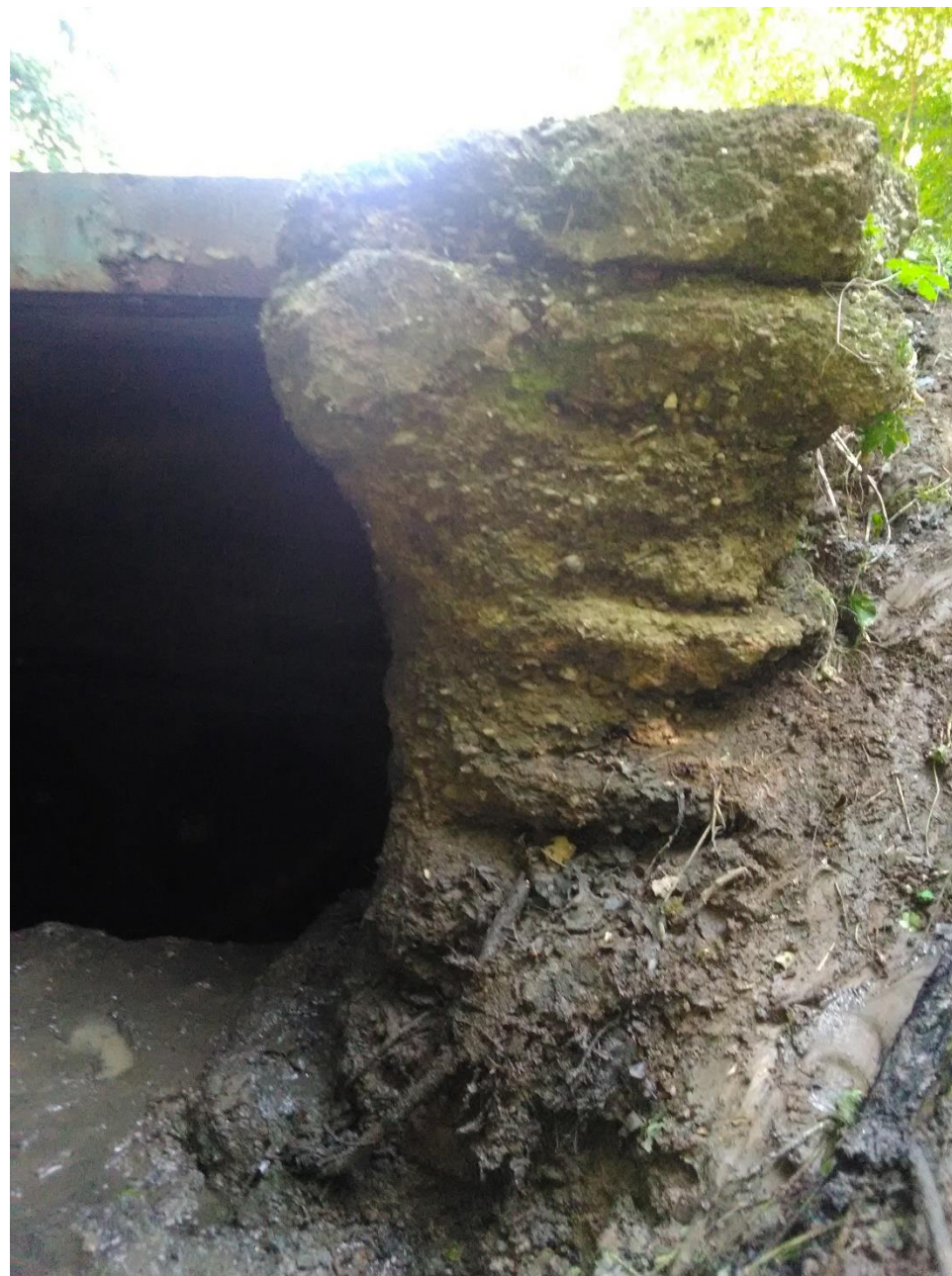
FOTO č.10 – vtokový objekt, degradace betonu na PB
