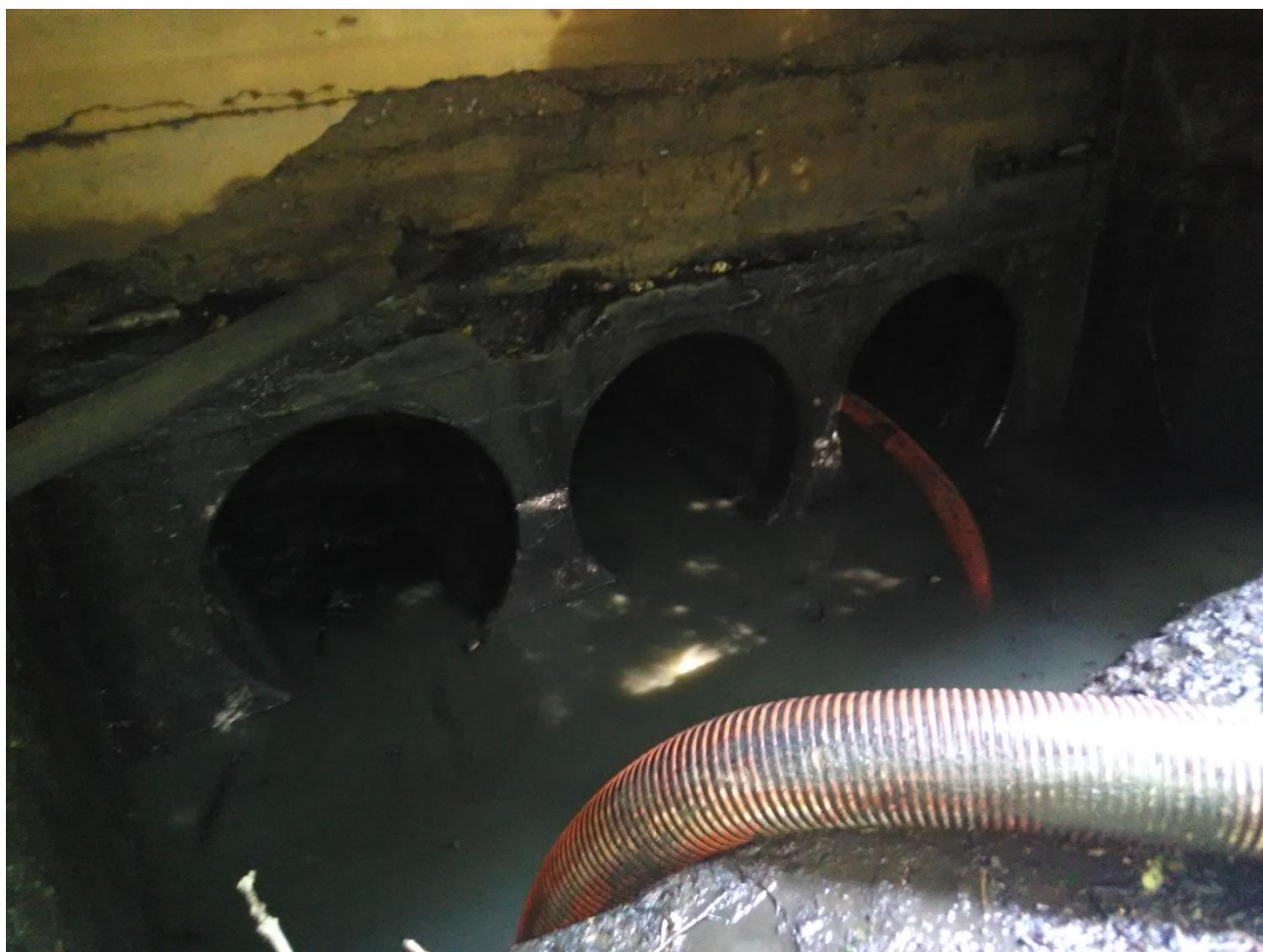
FOTO č.6 – vtokový objekt, potrubí 3x DN1000
