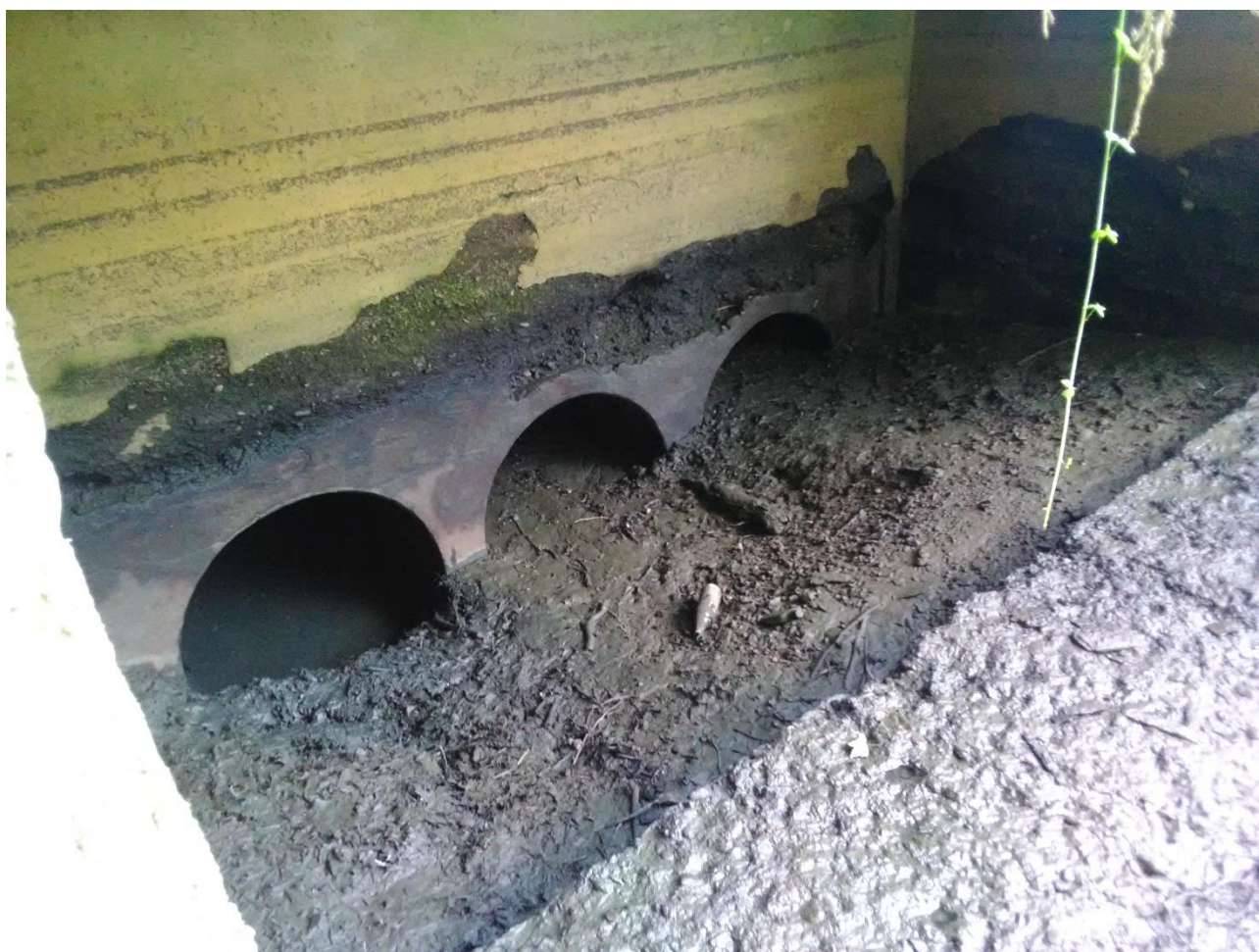
FOTO č.14 – výtokový objekt, potrubí 3x DN1000
