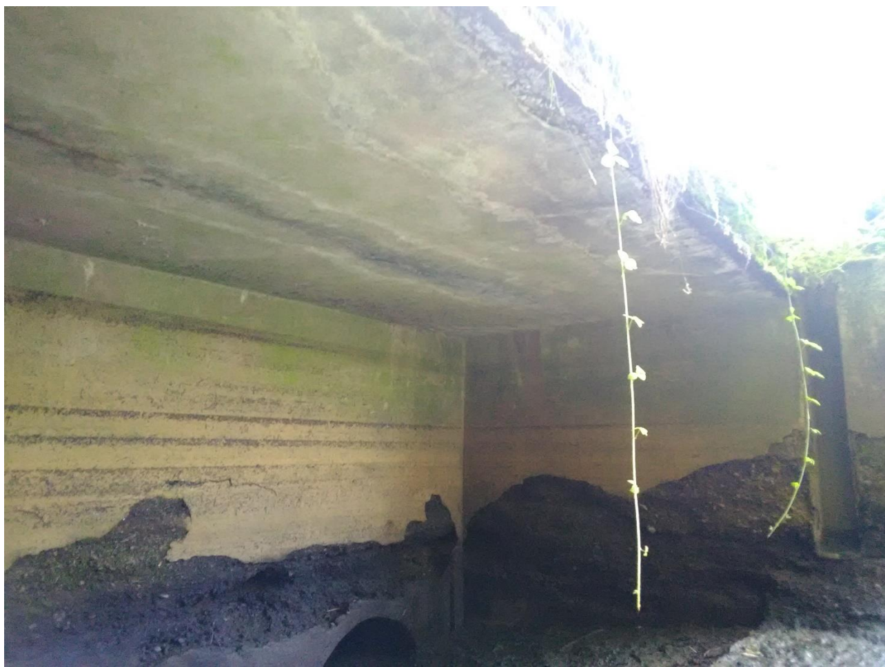
FOTO č.16 – výtokový objekt, degradace betonu na LB
