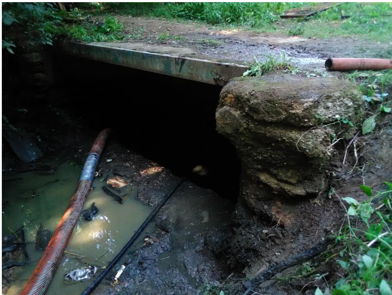
FOTO č.5 – vtokový objekt, při vyčerpání vody
