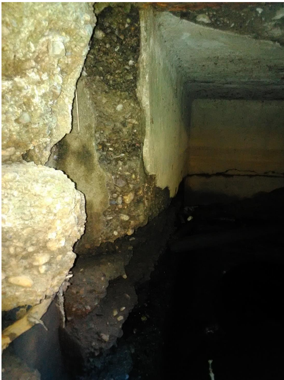
FOTO č.9 – vtokový objekt, degradace betonu na LB
